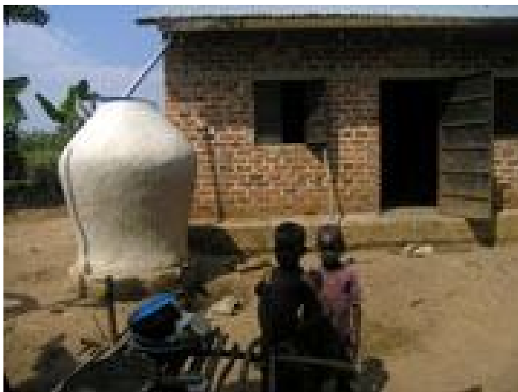
Fig. 6 Raccolta di acqua piovana dai tetti in un villaggio dell'Uganda (Fonte: website della World Bank).
